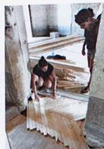
It Costruzione di Casa di BelMondo, Belmonte Calabro. Foto: Nicola Barbuto En Construction of Casa di BelMondo, Belmonte Calabro. Photo: Nicola Barbuto
